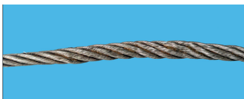
значительный износ проволок канат большой угол девиации; высокое опорное давление; абразивный износ; заклинивание шкивов;
